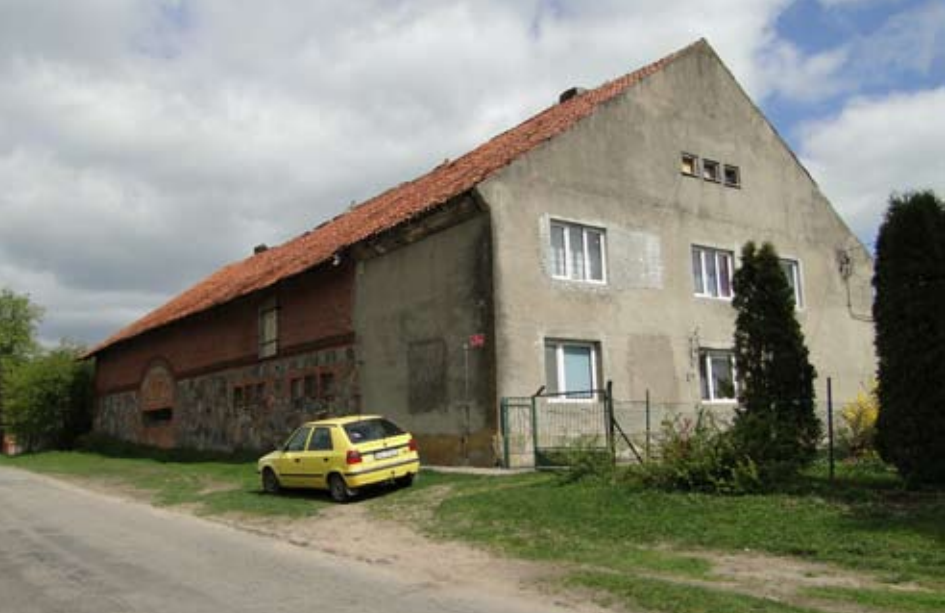
Przykład przedwojennej zabudowy z dwuspadowym dachem krytym dachówką
