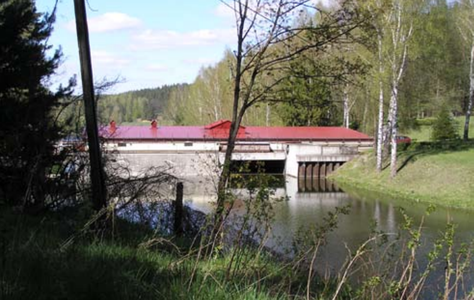
Elektrownia wodna w Brąswaldzie
