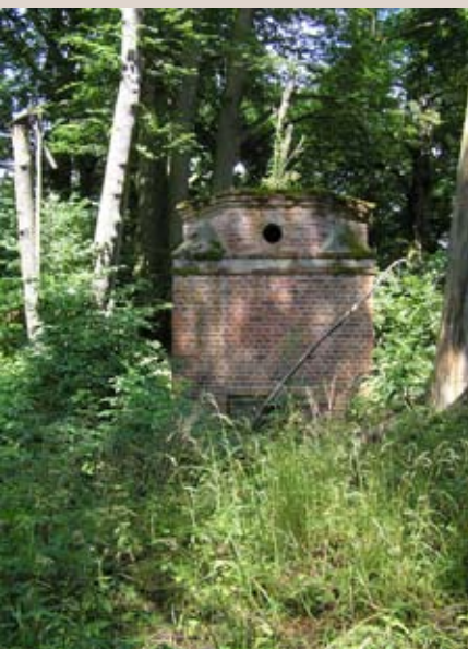
Zrujnowana kaplica cmentarna
