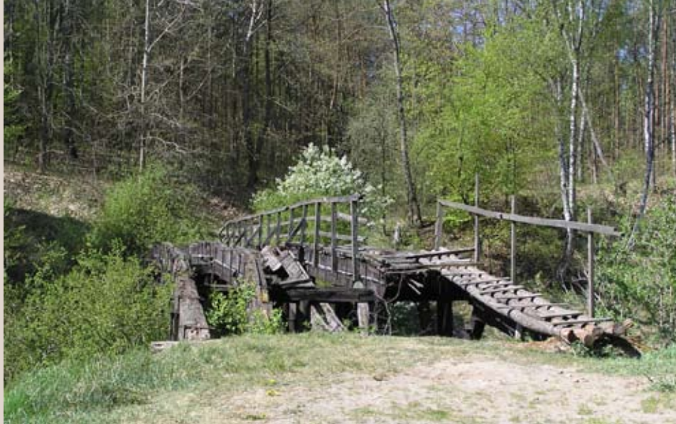
Zniszczona kładka na Łynie
